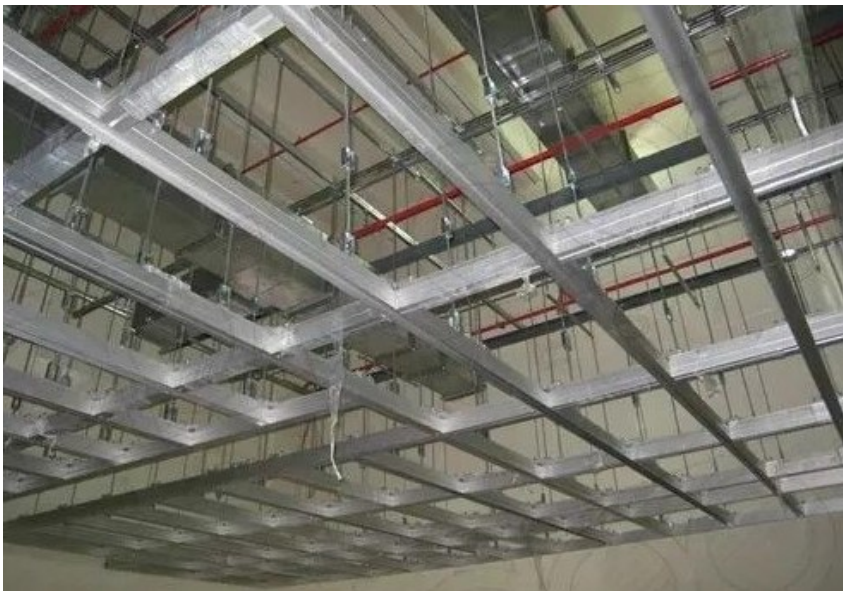
图1 吊顶防火笼
